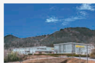
●岡山第二工場
